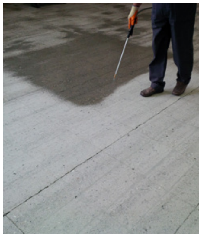
Applicazione a spruzzo X-tra LQ per impermeabilizzazione superficiale
